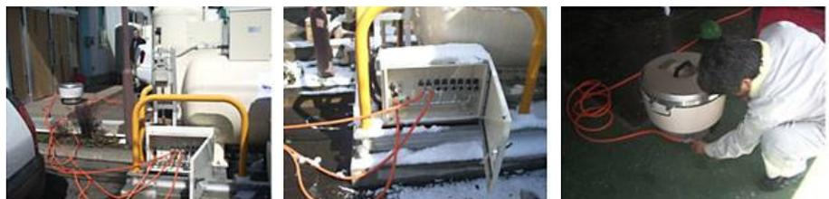
バルク貯槽ユニットに備え付けられたガス栓にホースを接続し、消費機器と接続します。接続はワンタッチカップリング方式なのでどなたでも簡単に接続できます。
